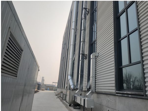
挤出工序配套废气净化设备
